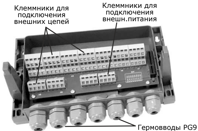
Рис. 2.4 – Вид на монтажный отсек при снятой крышке
